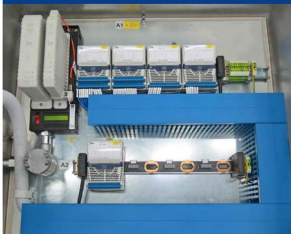
Einsatz des Ethernet Remote I/O-Systems IS1+ in einer Lackieranlage in den USA mit Netzwerk-Anbindung über das PROFINET-Protokoll.
