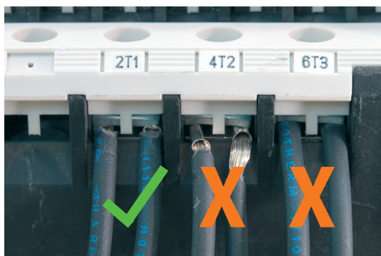
Bild 6: Richtiges und falsches Auflegen der Leitungen
