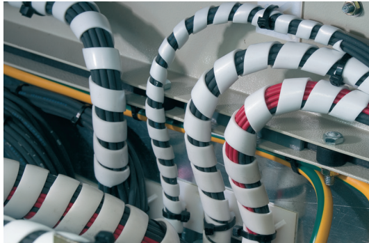
Bild 7: Getrennte Bündelung von Leitern
