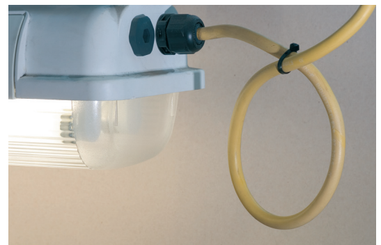
Bild 5: Kabelschleife schützt vor Eindringen des Wassers
